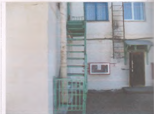
Фото №32 – Пути эвакуации(запасной выход здания «А» 2 этаж)
