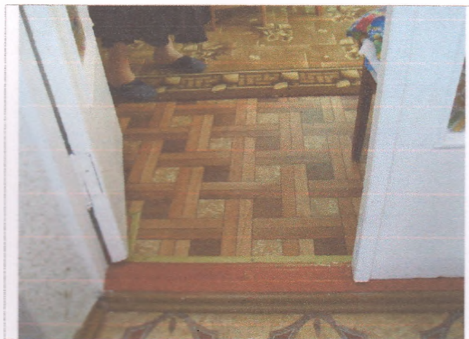
Фото №50 – Двери внутри здания
