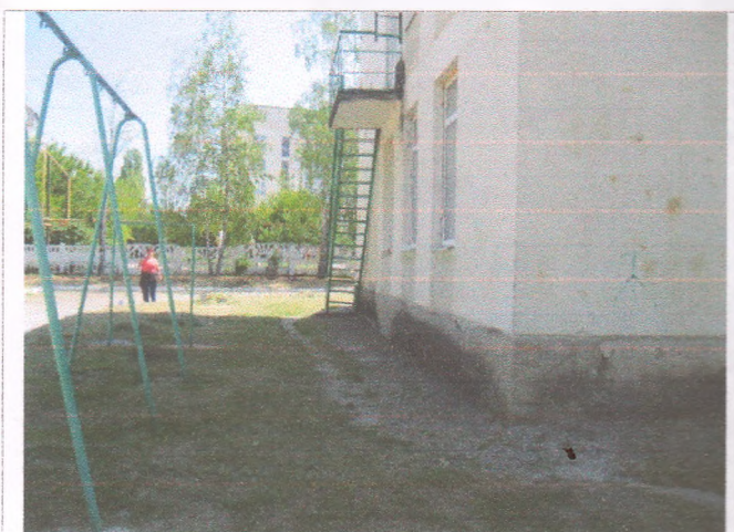
Фото №63 – Пути эвакуации(запасной выход здания «Б» 2 этаж)
