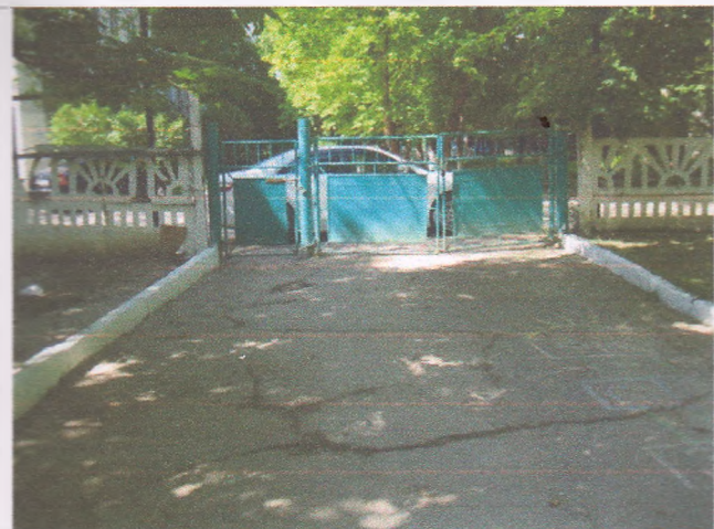
Фото №3 – Вход на территорию (со стороны водоканала)
