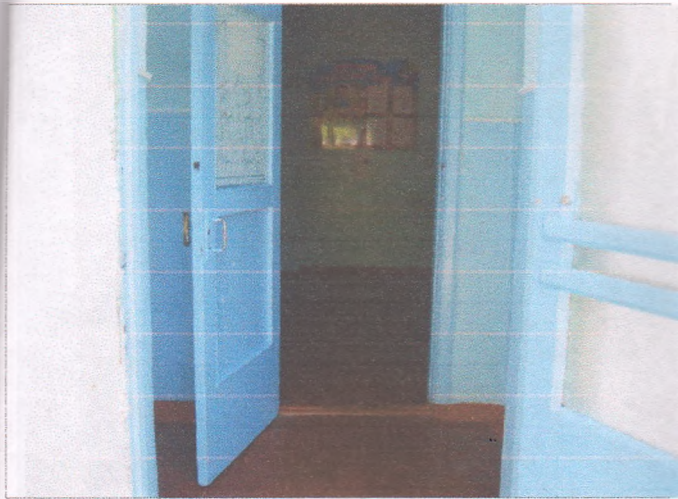
Фото №37 – Тамбур здания «Б»
