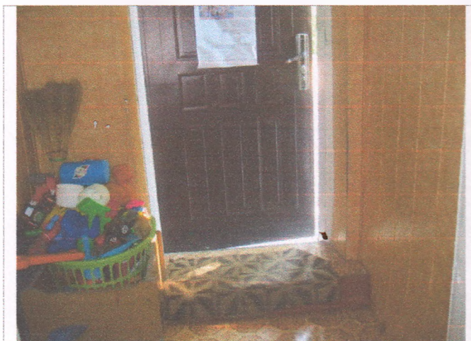
Фото №33 – Пути эвакуации
