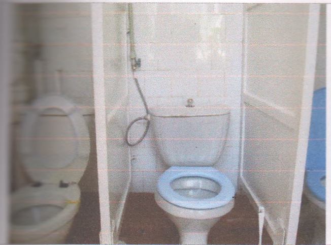
Фото №25 – Санитарно-гигиенические помещения
