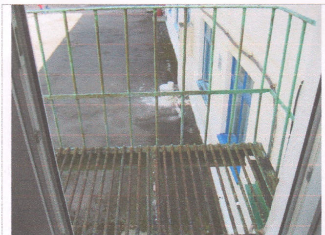
Фото №31 – Пути эвакуации(запасной выход здания «А» 2 этаж)
