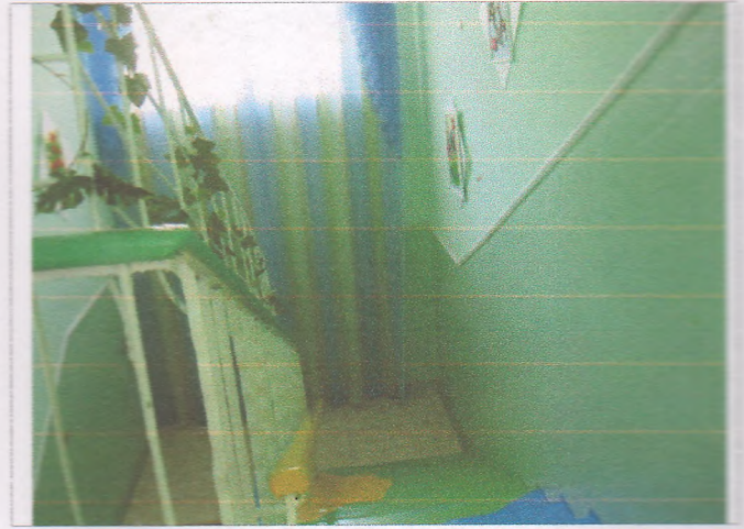
Фото №14 – Лестница внутри здания
